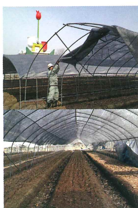
遮光ネット被覆作業
